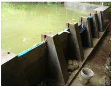
Fotografía Nº 1 Presa abastecedora de agua
